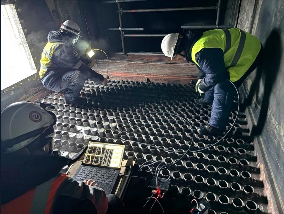
Ввод преобразователя в трубку теплообменника
